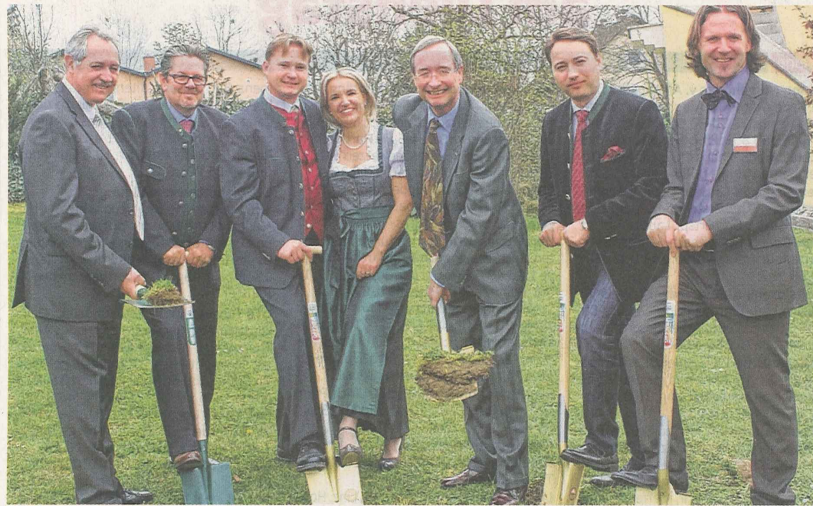
Ein Spatenstich wie für ein großes Landesprojekt – doch hier entsteht ein energieautarkes Einfamilienhaus. (privat)
